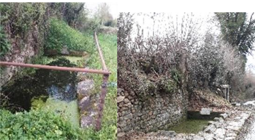
Rénovation d'un ensemble lavoir, fontaine, murets Bussière Nouvelle
